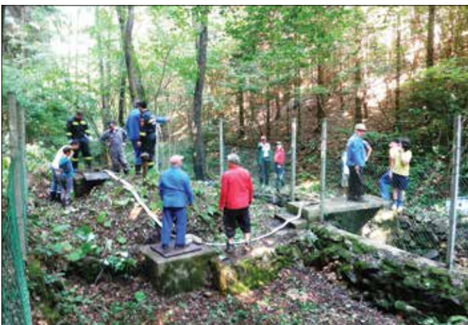
Urejanje in čiščenje rezervoarja pri vodovodu v Brezjah leta 2011.
