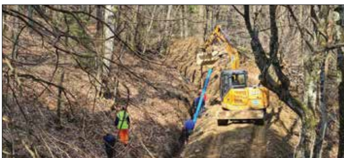
Gradbena dela sklop 6
