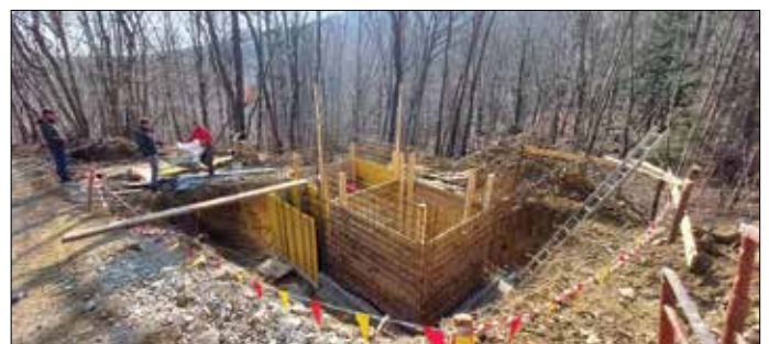
Gradbena dela sklop 11
