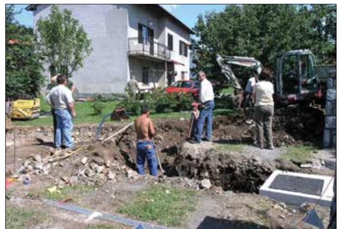
Gradnja vodovoda po vasi leta 2009.
