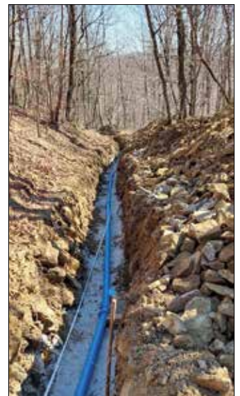
Gradbena dela sklop 11
