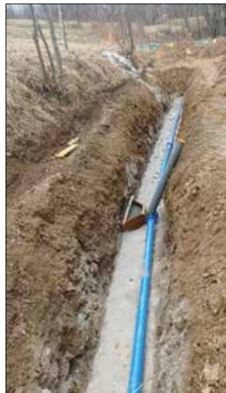
Gradbena dela sklop 10
